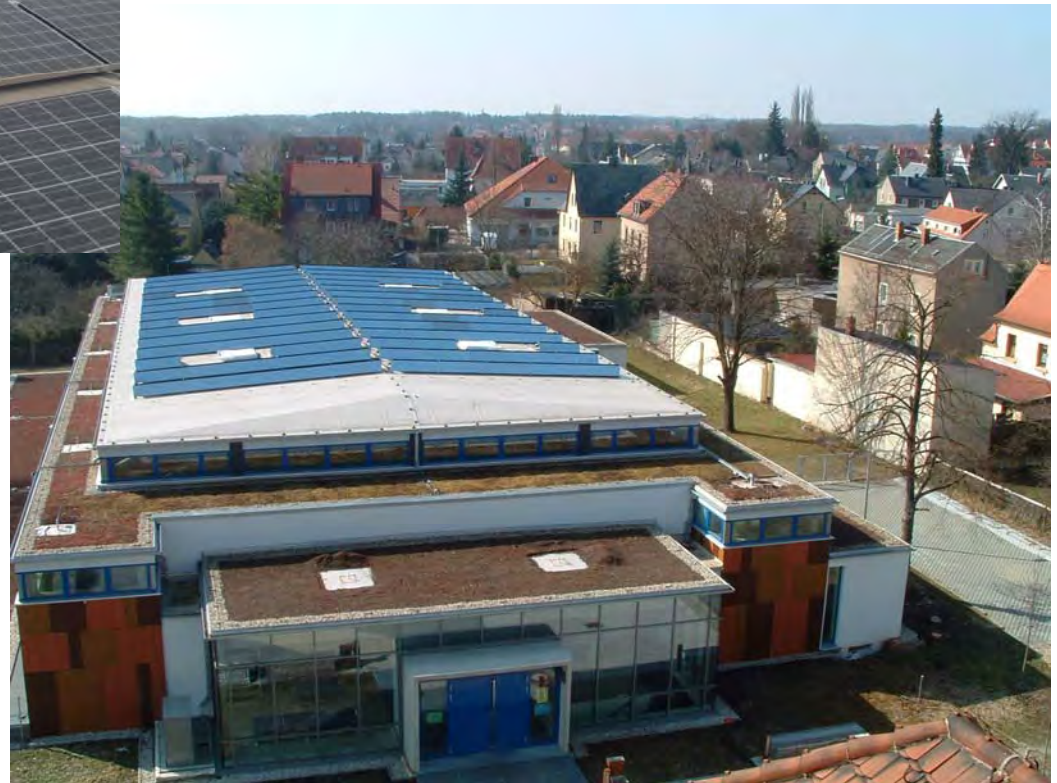
Gesamtansicht solarelektrische Anlage, Eingangsbereich und Dachbegrünung
