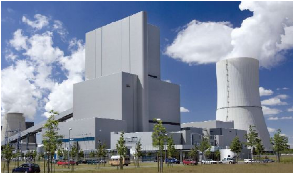
Bild: Kraftwerk Boxberg (Quelle: Cofely Anlagenbau Dresden)
