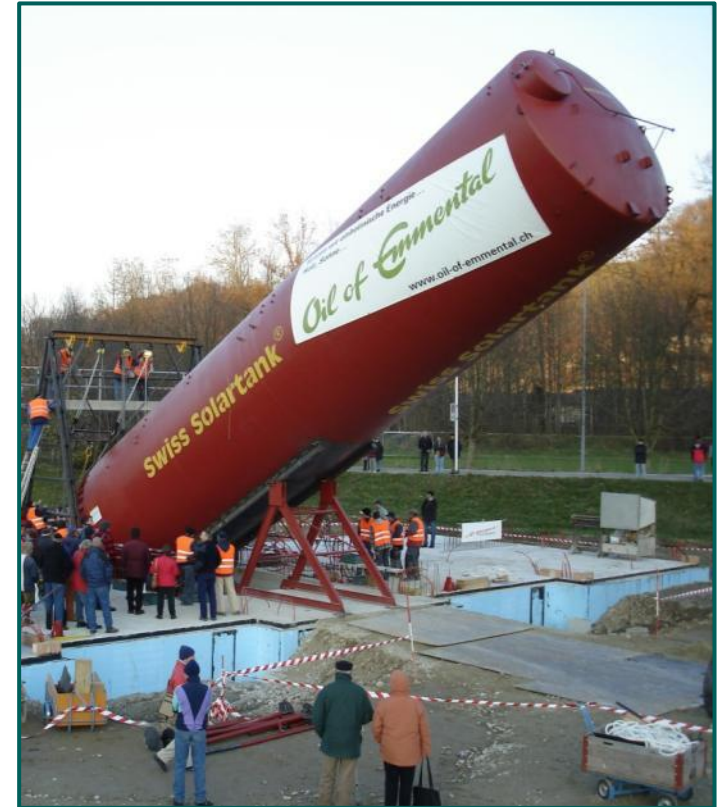
Quelle: SAENA; Broschüre Solarthermiehäuser
