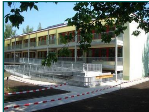
Sanierung Plattenbau-Kita in Chemnitz
