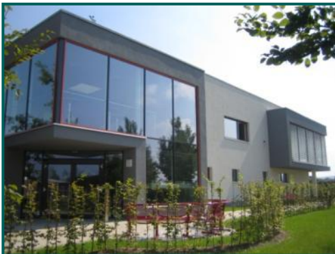
Bürogebäude in Bautzen
