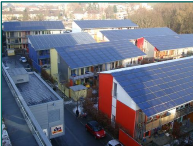
Solarsiedlung „Sonnenschiff“ in Freiburg von Rolf Disch
