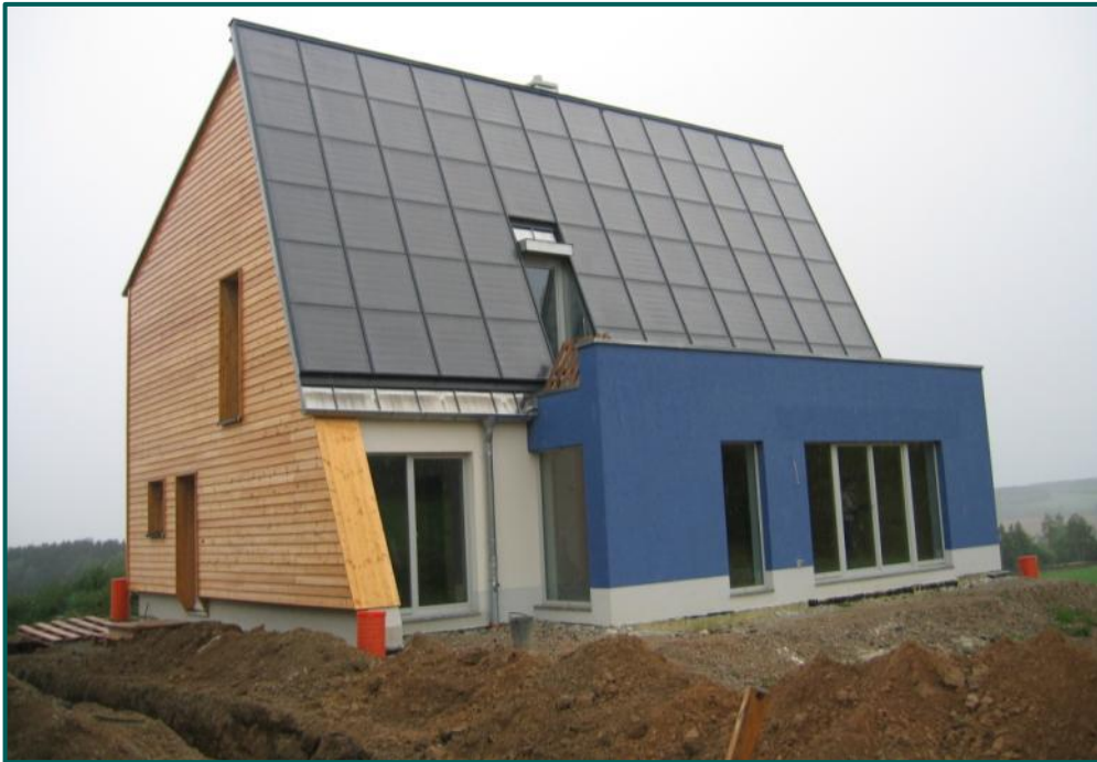
Quelle: SAENA; Broschüre Solarthermiehäuser
