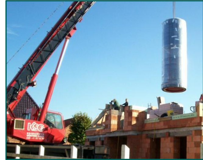
Quelle: SAENA; Broschüre Solarthermiehäuser
