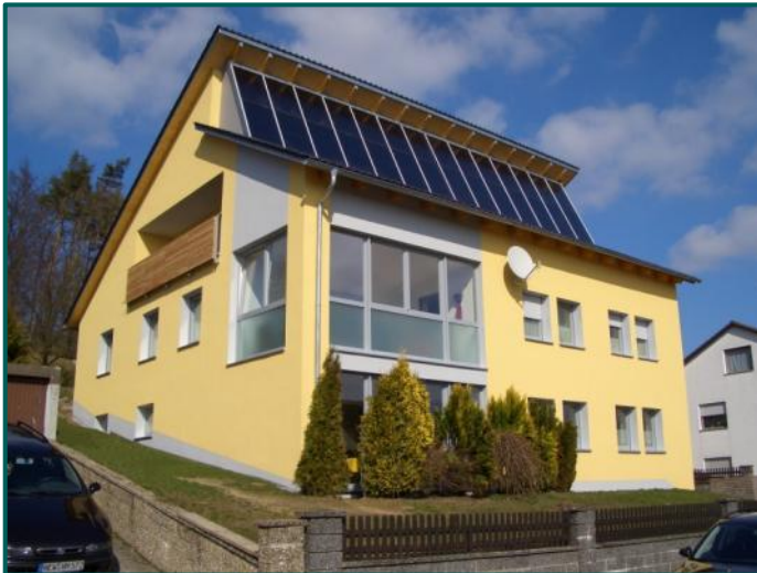
Quelle: SAENA; Broschüre Solarthermiehäuser
