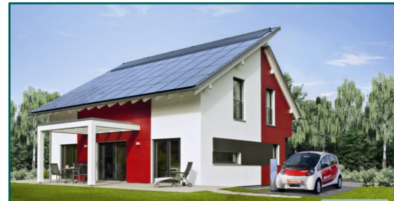
Quelle: SAENA; Broschüre Solarthermiehäuser
